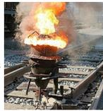
Nach der Zündung des Gemisches fließt flüssiges Eisen in die Schienenlücke.
